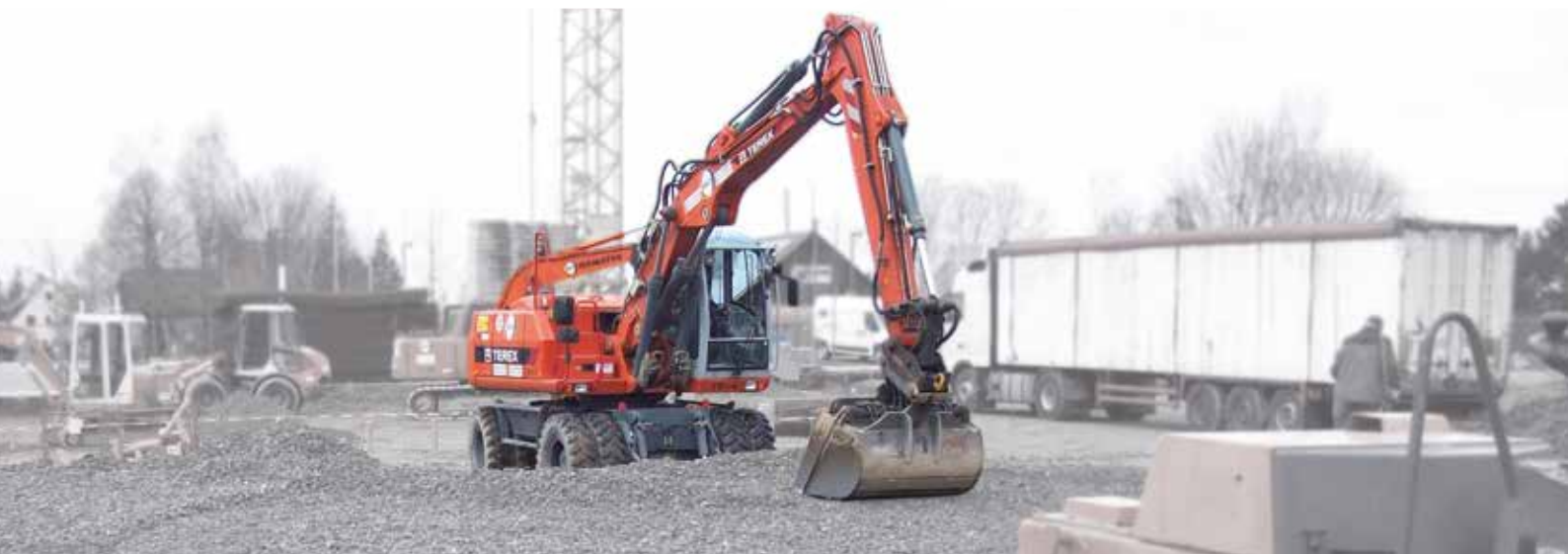
Großflächiger Einbau von veriso Schaumglas für eine Produktionshalle
